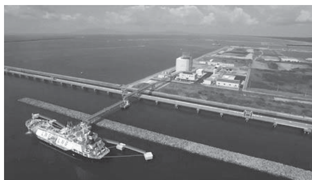
(秋田LNG受入基地)
